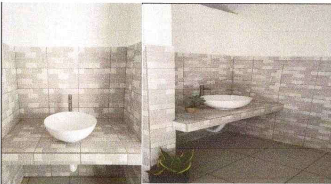
Foto 3: SUSTITUCIÓN DE LAVAMANOS
