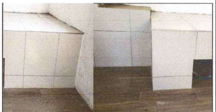
Foto 6: SUSTITUCIÓN DE PISO EN COCINA
