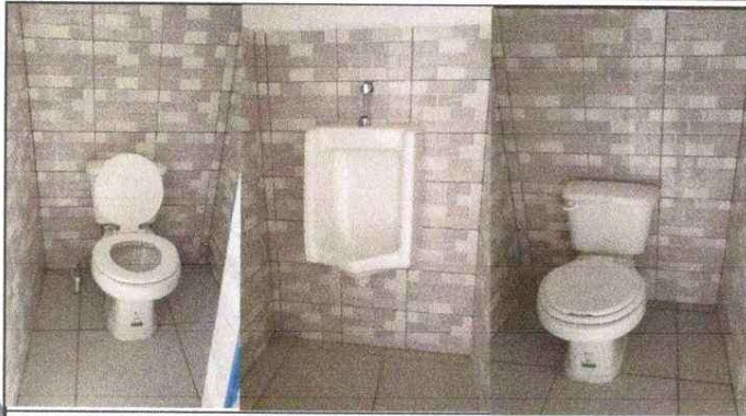
Foto1: SUSTITUCIÓN DE INODOROS
