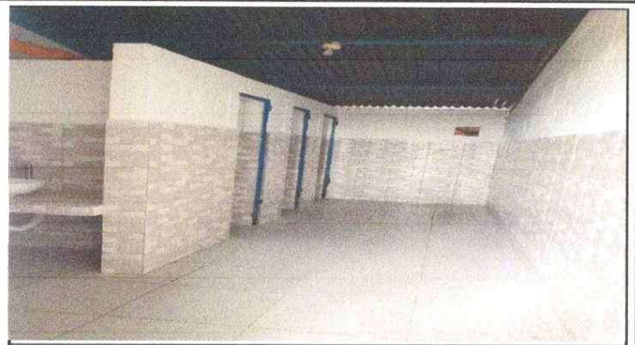
Foto 2: SUSTITUCIÓN DE PISO
