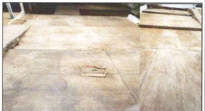
Foto 4: SUSTITUCIÓN DE PISO DE CONCRETO
