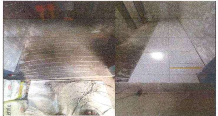
Foto 2: SUSTITUCIÓN DE PISO
