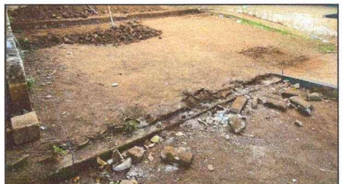
Foto 4: SUSTITUCIÓN DE PISO DE CONCRETO
