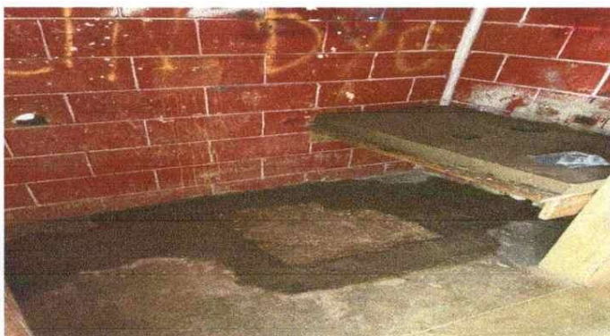
Foto 3: SUSTITUCIÓN DE LAVAMANOS
