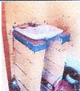
Foto 3: SUSTITUCIÓN DE LAVAMANOS
