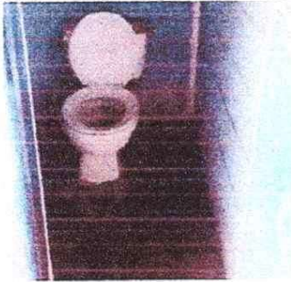
Foto 1: SUSTITUCIÓN DE INODOROS
