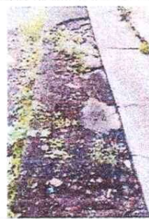
Foto 4: SUSTITUCIÓN DE PISO DE CONCRETO
