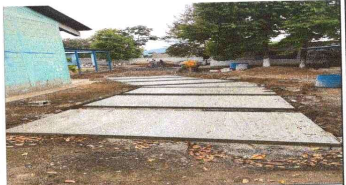
Foto 4: Cambio de pavimento de concreto
