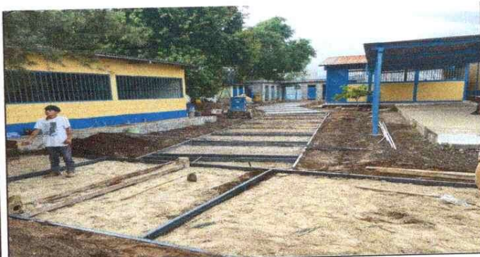
Foto 5: Sustitución de base de concreto
