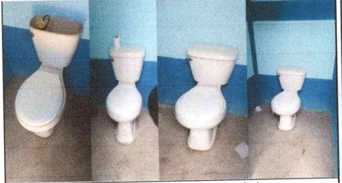
Foto 2: Reparación de Santiarios (cambio de accesorios)
