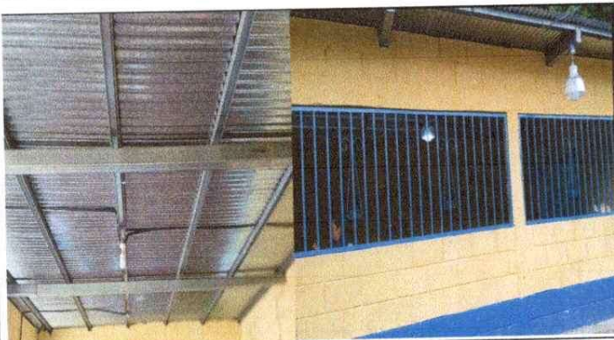
Foto 3: MEJORAMIENTO DE INSTALACIONES ELECTRICAS
