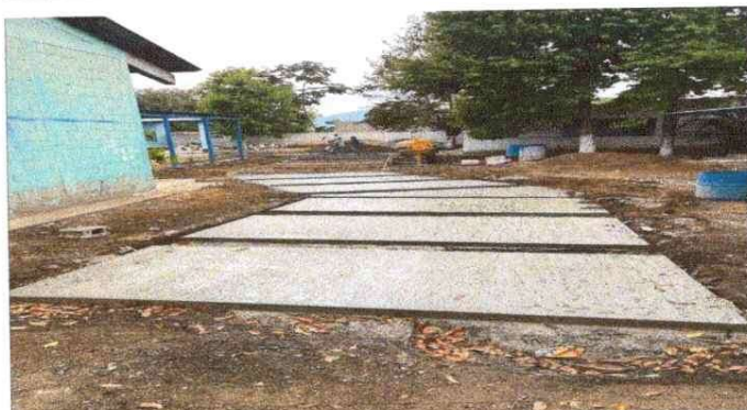
Foto 4: Cambio de pavimento de concreto
