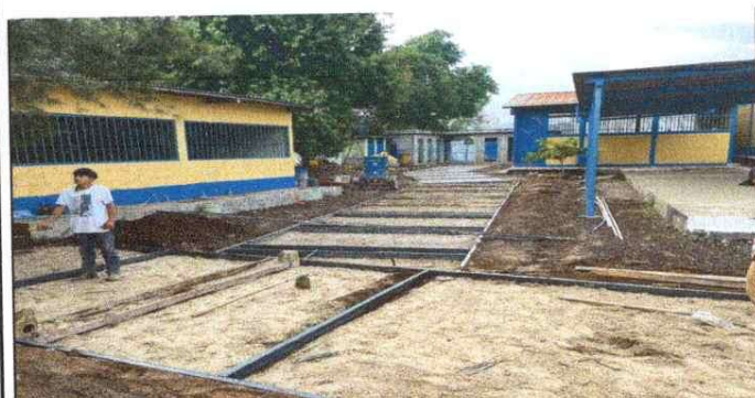
Foto 5: Sustitución de base de concreto
