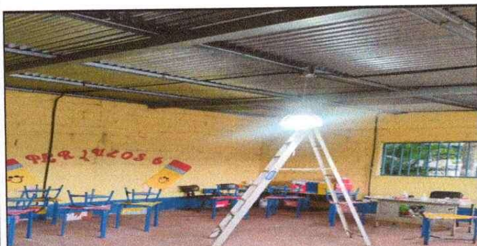
Foto 3: MEJORAMIENTO DE INSTALACIONES ELECTRICAS
