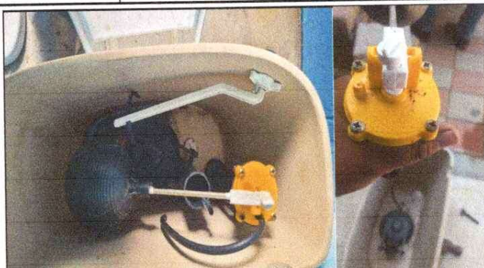
Foto 2: Reparación de Santiarios (cambio de accesorios)
