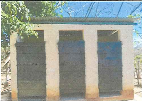
FOTO 5: VISTA FRONTAL DE BAÑOS A MODIFICAR
