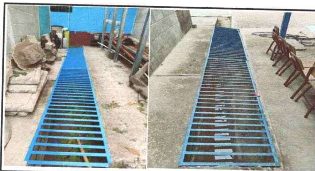
Foto 6: SUSTITUCIÓN DE REJILLAS METÁLICAS
