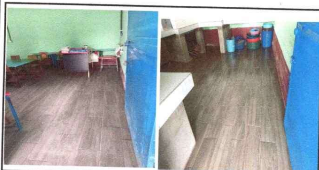
Foto 5: INSTALACIÓN DE PISO CERÁMICO
