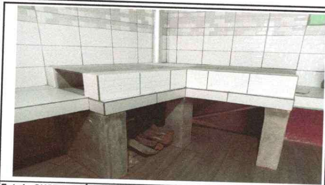
Foto 1: SUSTITUCIÓN DE COCINA RURAL COMPLETA
