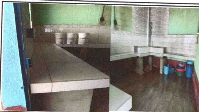
Foto 2: MEJORAMIENTO DE MUEBLE DE COCINA
