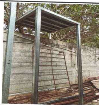
Foto 4: BASE METÁLICA PARA TINACO
