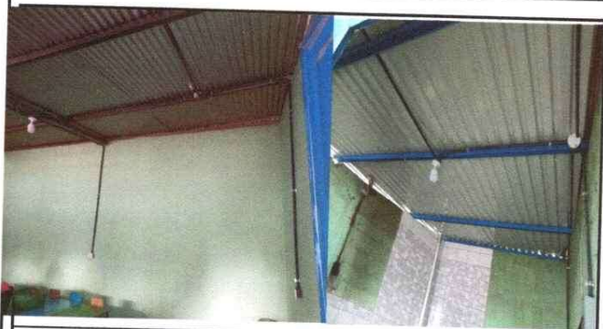
Foto 3: INSTALACIONES ELECTRICAS EN AULA Y COCINA
