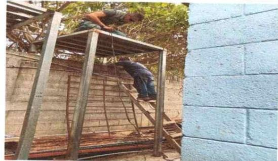
Foto 4: BASE METÁLICA PARA TINACO
