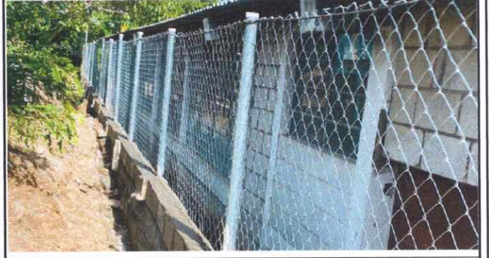
Foto 2: distancia del muro perimetral 32 m, área 64 m2
