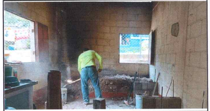
FOTO: 4 SUSTITUCION DE 3 VENTANAS POR VENTANAS CORREDIZAS DE PVC BLANCO CON VIDIRO DE 5 MM TRANSPARENTE
