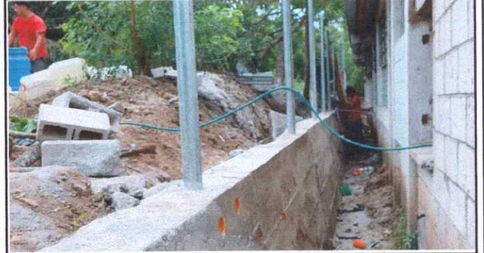
Foto 2: distancia del muro perimetral 32 m, área 64 m2
