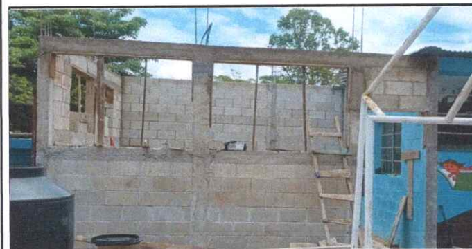
Foto 5: meioramiento de bodega de usos múltiples
