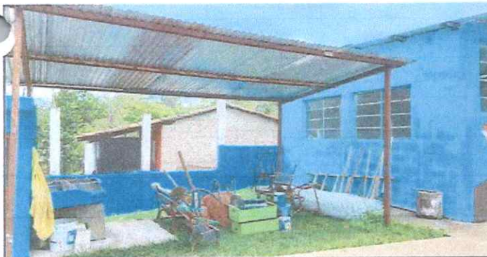
Foto 5: meioramiento de bodega de usos múltiples
