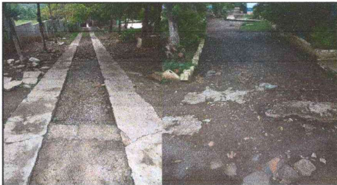
Foto 3: MEJORAMIENTOS Y Reparacion de la torta de la acera de entrada al establecimiento
