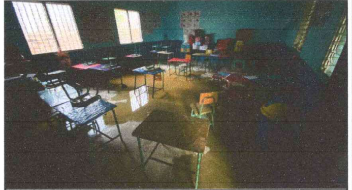
Foto 2: MEJORAMIENTO ESTRUCTURA DE TECHO, SUSTITUCION DE ESTRUCTURA DE SOPORTE DE METAL POR METAL, POR FILTRACION DE AGUA EN LAS AULAS
