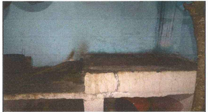
Foto 4: REPARACION DE COCINA, MEJORAMIENT DE ESTUFA RURAL
