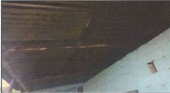
Foto 1: SUSTITUCION DE ELEMENTOS DE FIJACION, DE ESTRUCTURA DE SOPORTE DE METAL POR METAL, DE LAMINA POR LAMINA TROQUELADA ALUZINC, DE CAPOTE DE LAMINA PARA LAMINA TROQUELADA
