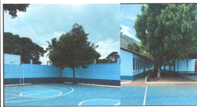
Foto 5: PINTURA EN MURO EXTERIOR E INTERIOR
