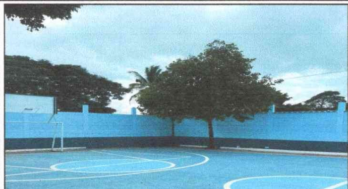
Foto 1: REPARACION DE MURO PERIMETRAL DE BLOCK
