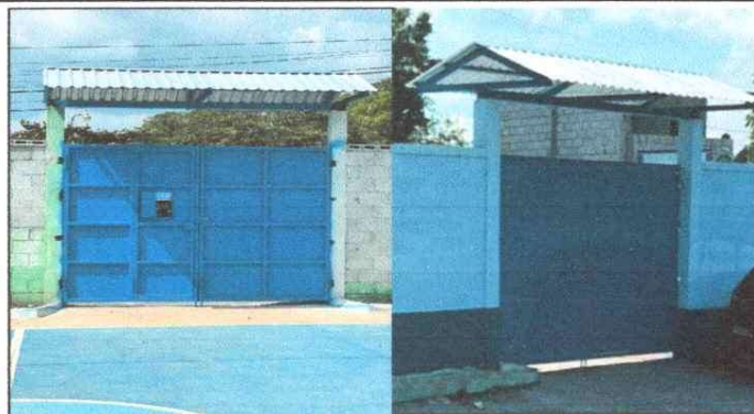
Foto 2: MEJORAMIENTO DE PORTON PRINCIPAL
