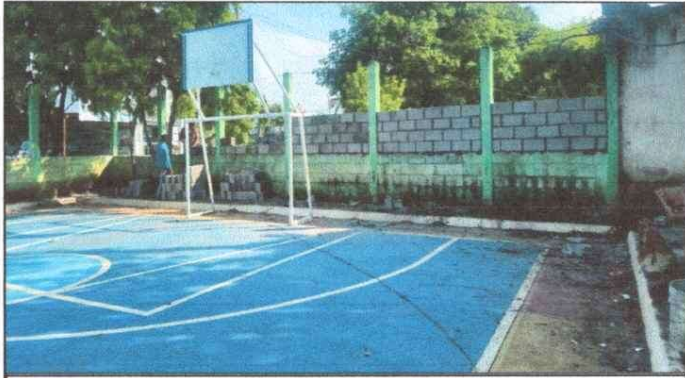
Foto 1: REPARACION DE MURO PERIMETRAL DE BLOCK
