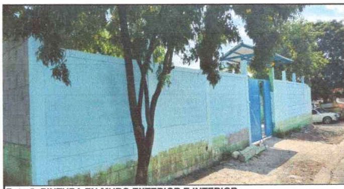
Foto 5: PINTURA EN MURO EXTERIOR E INTERIOR
