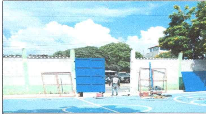
Foto 2: MEJORAMIENTO DE PORTON PRINCIPAL
