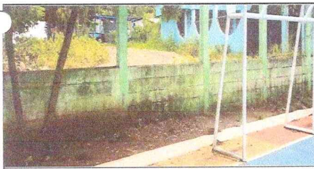
Foto 5: PINTURA EN MURO EXTERIOR E INTERIOR
