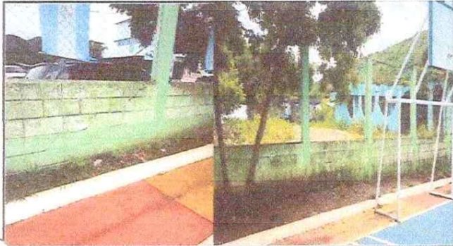
Foto 1: REPARACION DE MURO PERIMETRAL DE BLOCK
