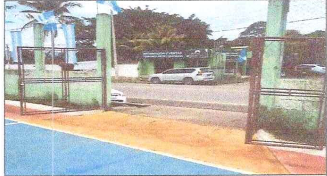
Foto 2: MEJORAMIENTO DE PORTON PRINCIPAL
