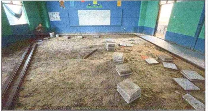
Foto 2: SUSTITUCIÓN DE PISO DE GRANITO
