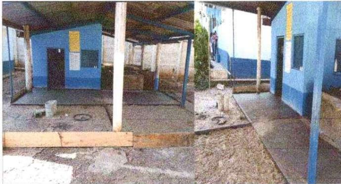
Foto 3: FUNDICIÓN DE PISO DE CONCRETO
