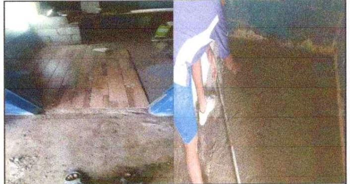
Foto 4: FUNDICIÓN DE PISO DE CONCRETO Y PISO CERAMICO ANTIDESLIZANTE
