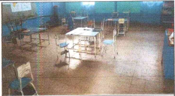
Foto 2: SUSTITUCIÓN DE PISO DE GRANITO
