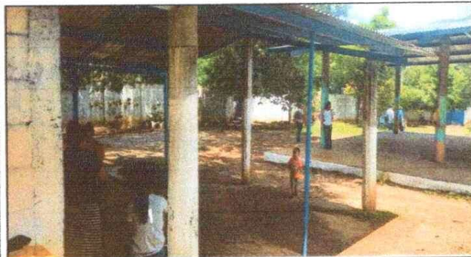
Foto 3: FUNDICIÓN DE PISO DE CONCRETO
