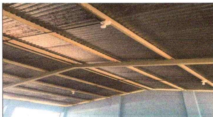
Foto 3: reparacion de lamparas, sustitucion de toma corrientes dobles.
