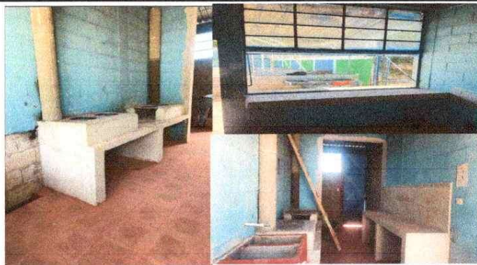
Foto 2: Sustitucion de estufa rural completa incluye chimenea y plancha de metal. Puerta de metal, fabricacion e instalacion de puerta de metal en cocina.
