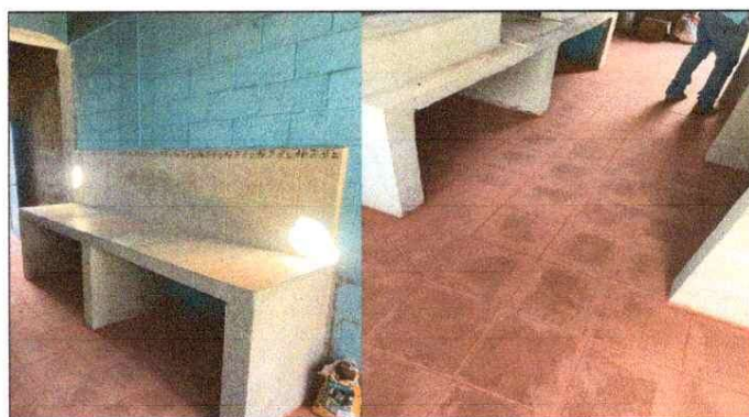
Foto 4: Mejoramiento en Cocina y mueble de cocina
