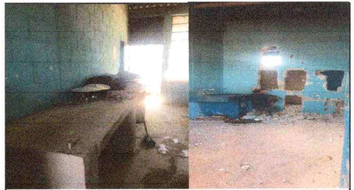
Foto 4: Mejoramiento en Cocina y mueble de cocina
