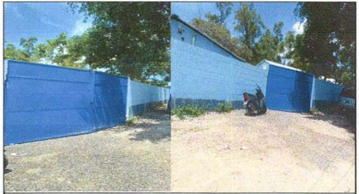
Foto 5: PINTURA EN MURO EXTERIOR E INTERIOR
