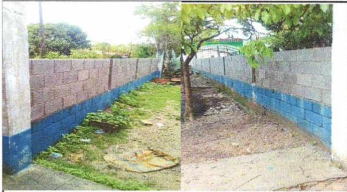
Foto 1: REPARACION DE MURO PERIMETRAL DE BLOCK
