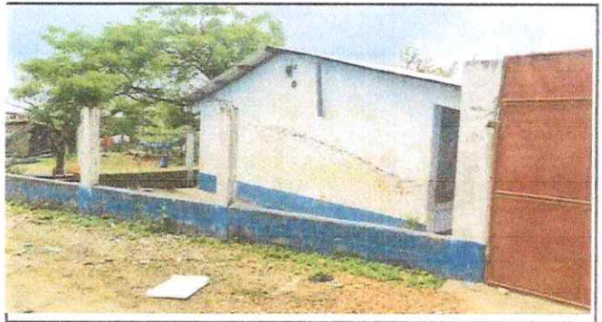
Foto 5: PINTURA EN MURO EXTERIOR E INTERIOR
