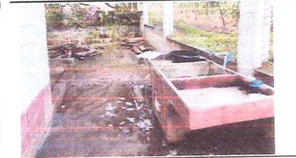
Foto 5: SUSTITUCION DE PILA POR PILA DE CONCRETO FABRICACION IN SITU
