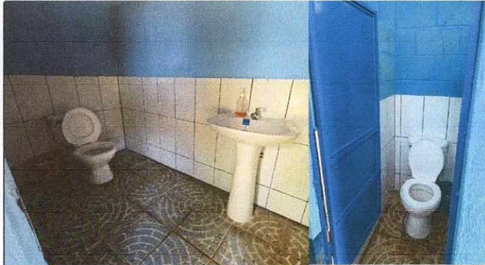
Foto 1: INSTALACION DE INODOROS,
