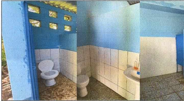
Foto 3: MEJORAMIENTO, REPARACION O SUTITUCION DE AZULEJO
