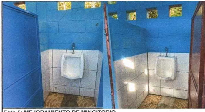
Foto 5: MEJORAMIENTO DE MINGITORIO
