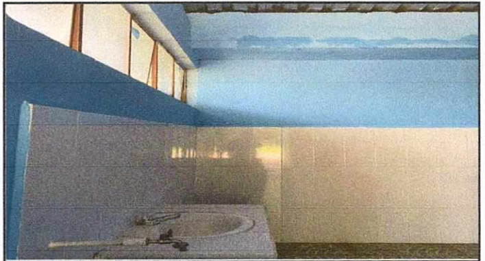
Foto 2: INSTALACION DE LAVAMANOS, CHORROS
