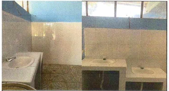
Foto 2: INSTALACION DE LAVAMANOS, CHORROS
