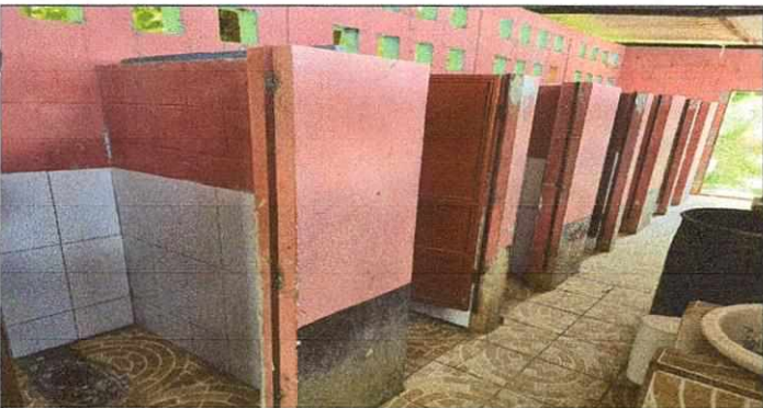
Foto 5: MEJORAMIENTO DE MINGITORIO
