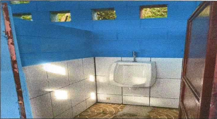
Foto 3: MEJORAMIENTO, REPARACION O SUTITUCION DE AZULEJO
