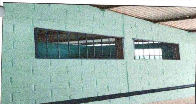
Foto 5: SUSTITUCIÓN DE ESTRUCTURA DE METAL DE VENTANA DE COCINA
