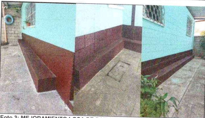
Foto 3: MEJORAMIENTO LOSA DE PATIO DE CONCRETO
