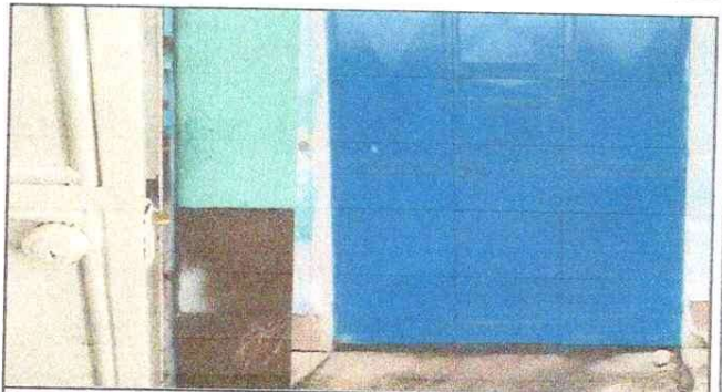
Foto 4: MEJORAMIENTO DE CHAPA EN PUERTA PRINCIPAL DE METAL
