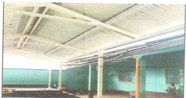
Foto 6: SUSTITUCIÓN DE ESTRUCTURA DE SOPORTE DE METAL, POR METAL
