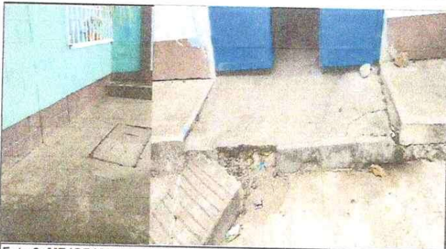
Foto 3: MEJORAMIENTO LOSA DE PATIO DE CONCRETO
