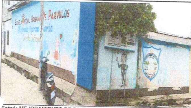
Foto 1: MEJORAMIENTO DE PINTURA EN MURO EXTERIOR E INTERIOR
