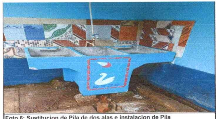
Foto 6: Sustitucion de Pila de dos alas e instalacion de Pila
