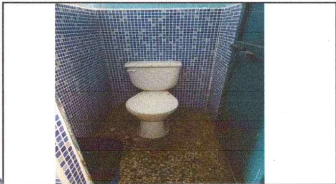
Foto 1: Sustitucion de de sanitarios por mal estado
