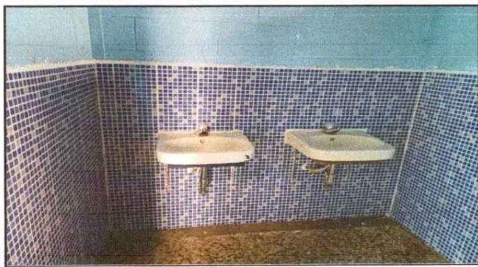
Foto 3: Sustitucion de lavamanos e instalacion de sus accesorios
