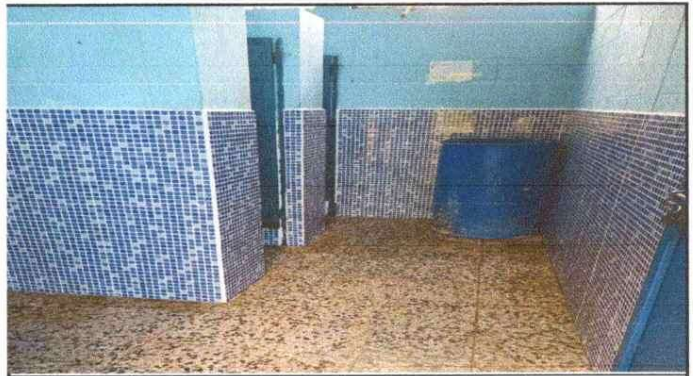
Foto 2: Mejoramiento de paredes con azulejo.
