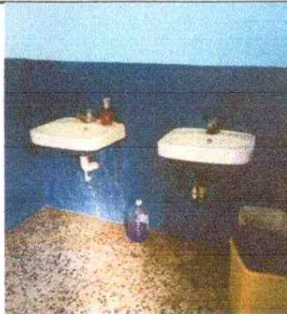
Foto 3: Sustrucción de lavamanos e instalación de sus accesorios
