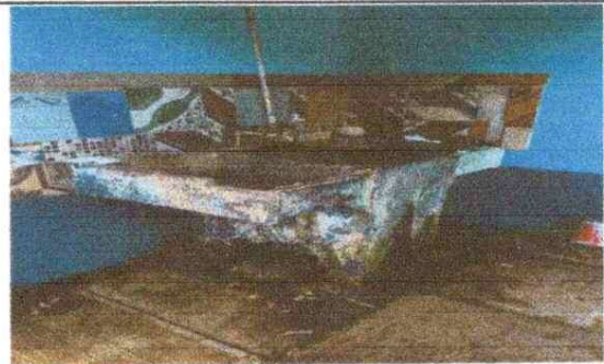
Foto 6: Sustrucción de Pila de dos alas e instalación de Pila
