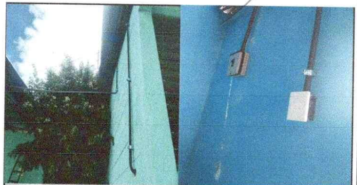
Foto 6: MEJORAMIENTO DE ACOMETIDA
