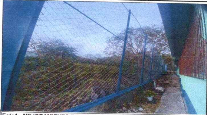
Foto 1: MEJORAMIENTO DE MURO PERIMETRAL
