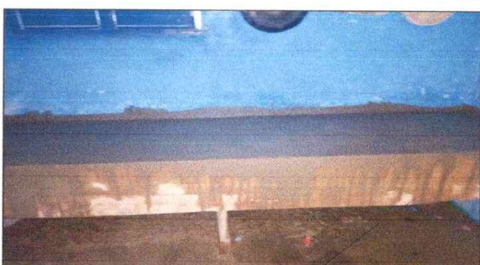
Foto 4: MEJORAMIENTO DE MUEBLE DE COCINA
