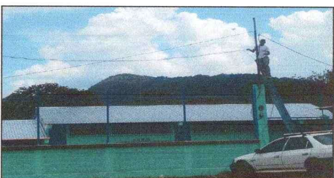
Foto 6: MEJORAMIENTO DE ACOMETIDA
