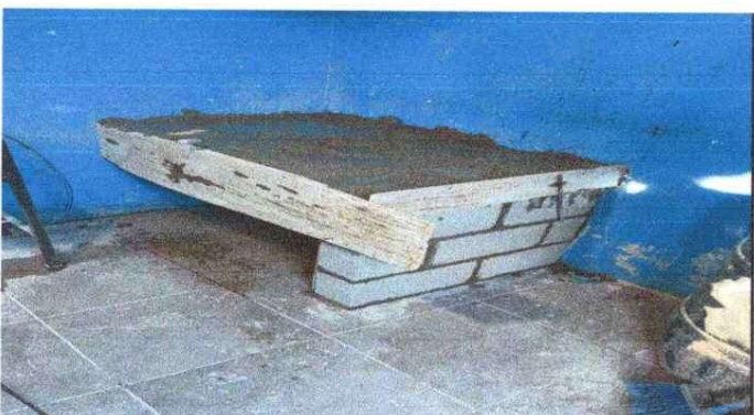
Foto 3: SUSTITUCIÓN DE COCINA RURAL (INCLUYE PLANCHA)
