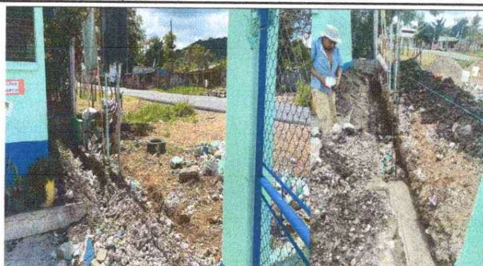
Foto 2: MEJORAMIENTO DE MURO DE PERIMETRAL DE BLOCK + CIMENTACIÓN
