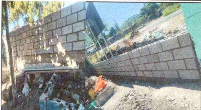
Foto 1: MEJORAMIENTO DE MURO PERIMETRAL
