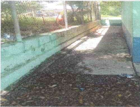
Foto 1: MEJORAMIENTO DE MURO PERIMETRAL
