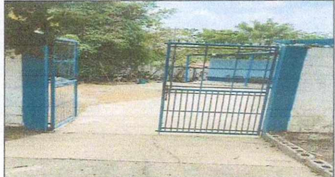
Foto 8: Mantenimiento y mejoramiento de portón de metal,
