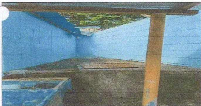
Foto 5: Mejoramiento de repello y sustitución de tapadera de metal
