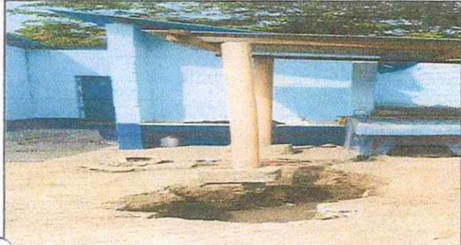
Foto 7: Mantenimiento de caja de registro, sustitución de tubería PVC, línea principal, agua negras, reparación de tapaderas de cajas, mantenimiento reposadera, limpieza de fosa séptica
