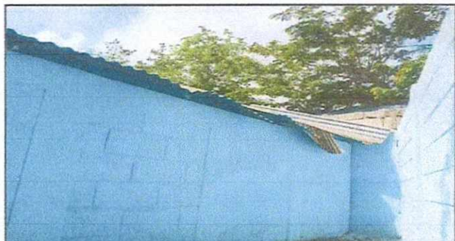
Foto 4: SUSTITUCION DE DEPOSITO DE AGUA 1100 LITROS (incluye base y tuberías) SUSTITUCION DE LAMINA POR LAMINA ALUZINC CALIBRE 26
