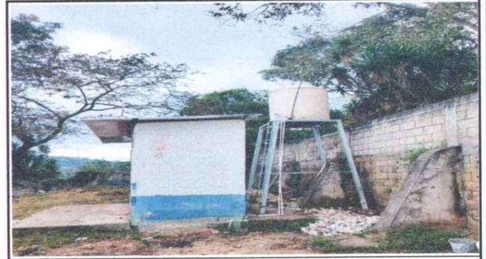
Foto 4: MEJORAMIENTOS EN SERVICIO SANITARIO
