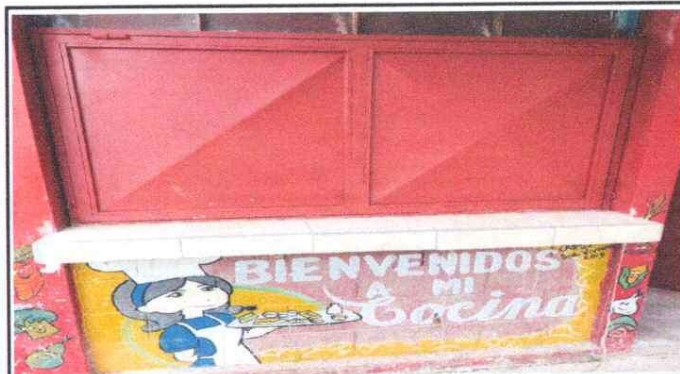
Foto 3: MEJORAMIENTO EN VENTANA DE COCINA
