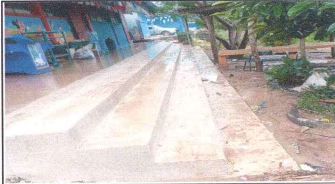
Foto 1: CONTENCIÓN A MODULO DE GRADAS POR DAÑO EN BANQUETA DE SALONES DE CLASE
