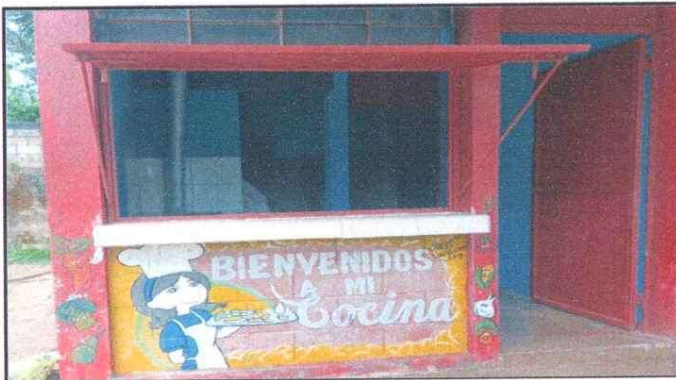
Foto 3: MEJORAMIENTO EN VENTANA DE COCINA
