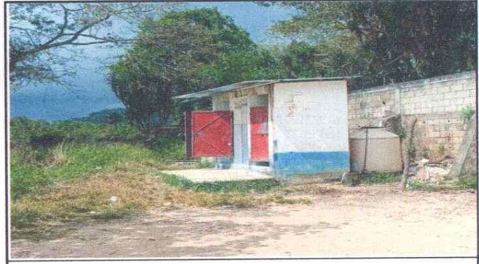
Foto 4: MEJORAMIENTOS EN SERVICIO SANITARIO
