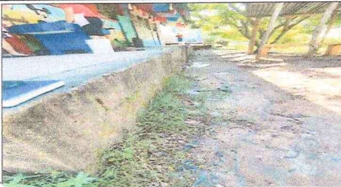
Foto 1: CONTENCIÓN A MODULO DE GRADAS POR DAÑO EN BANQUETA DE SALONES DE CLASES
