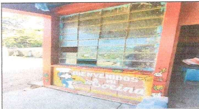
Foto 3: MEJORAMIENTO EN VENTANA DE COCINA
