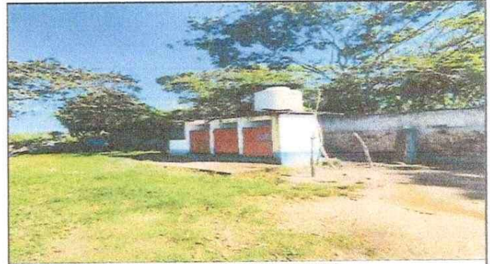
Foto 4: MEJORAMIENTOS EN SERVICIO SANITARIO
