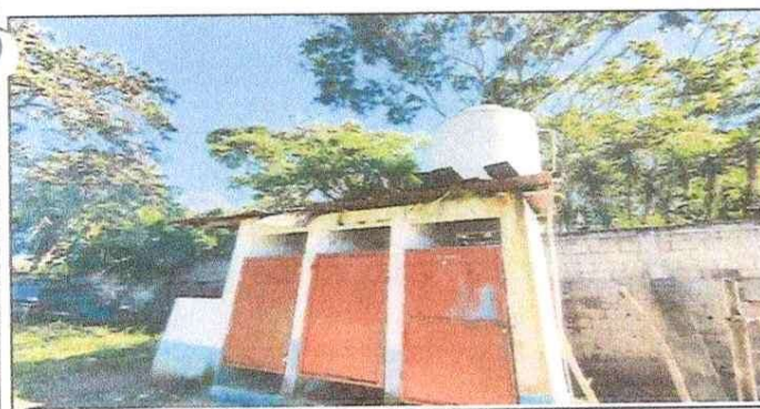
Foto 5: MANTENIMIENTO DE PUERTAS, INSTALACION DE TINACO EN TORRE, SUSTITUCION DE TECHO EN SERVICIOS SANITARIOS
