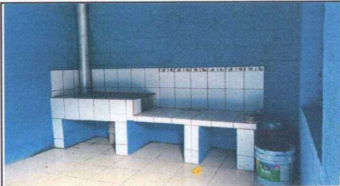
Foto 3: MEJORAMIENTO DE ESTUFA RURAL COMPLETA
