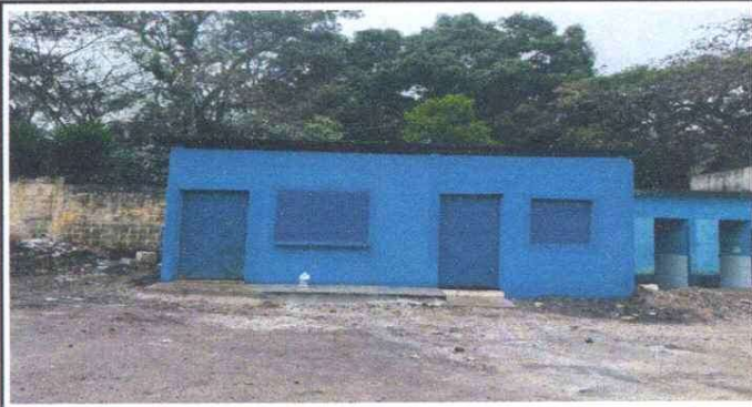
Foto 1: MEJORAMIENTOS EN COCINA
