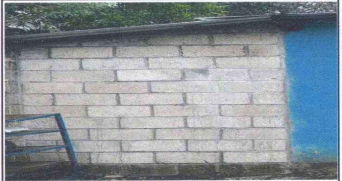
Foto 2: MEJORAMIENTO EN COCINA
