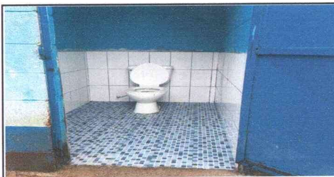
Foto 5: INSTALACIÓN DE AZULEJO EN SERVICIOS SANITARIOS
