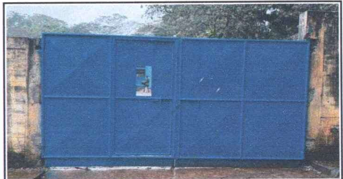
Foto 6: SUSTITUCIÓN DE PORTON
