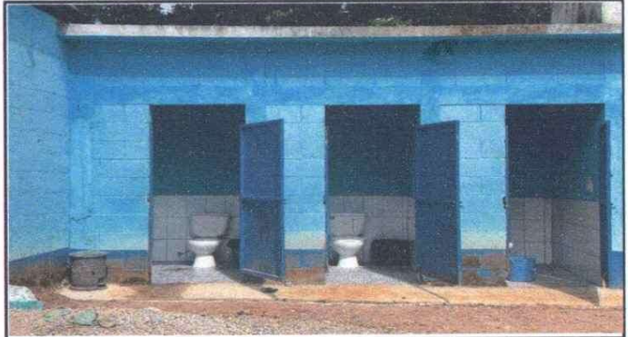
Foto 4: MEJORAS EN SERVICIOS SANITARIOS
