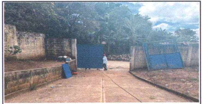
Foto 6: SUSTITUCIÓN DE PORTON
