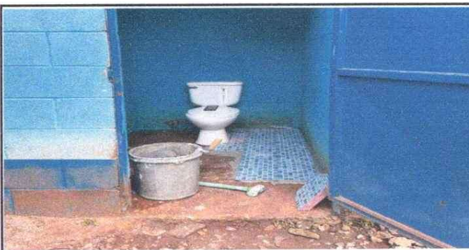
Foto 5: INSTALACIÓN DE AZULEJO EN SERVICIOS SANITARIOS
