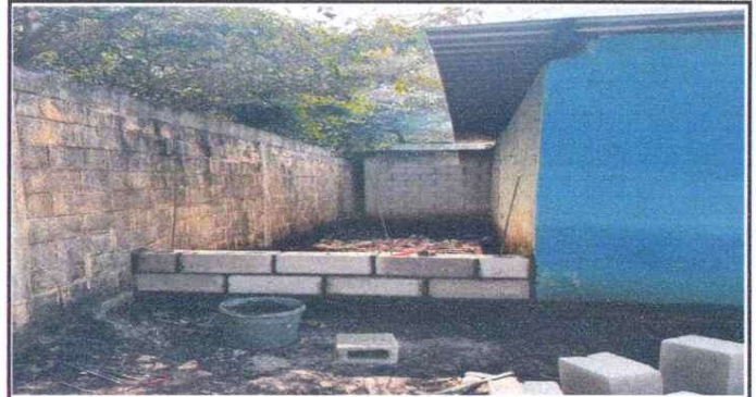
Foto 2: MEJORAMIENTO EN COCINA
