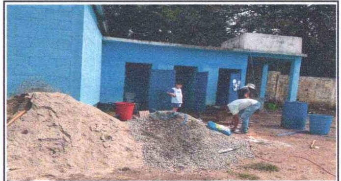
Foto 4: MEJORAS EN SERVICIOS SANITARIOS
