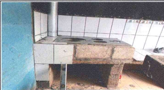
Foto 3: MEJORAMIENTO DE ESTUFA RURAL COMPLETA
