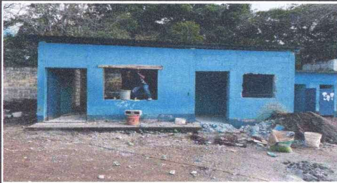
Foto 1: MEJORAMIENTOS EN COCINA
