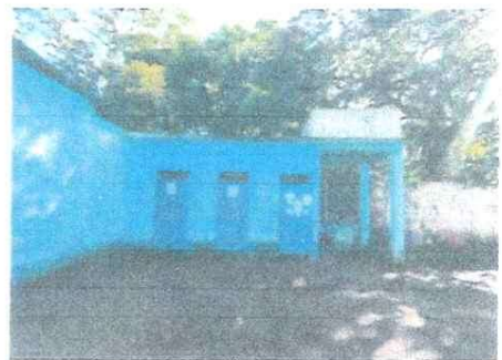
Foto 4: MEJORAS EN SERVICIOS SANITARIOS
