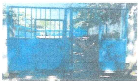
Foto 6: SUSTITUCION DE PORTON
