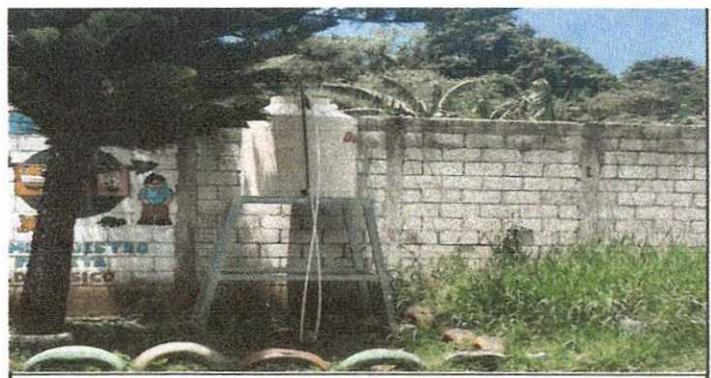
Foto6: SUSTITUCION DE DPOSITO DE AGUA DE 1100 LITROS (incluyendo base y tuberías).
