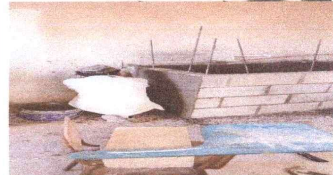
foto 4. construccion de pila
