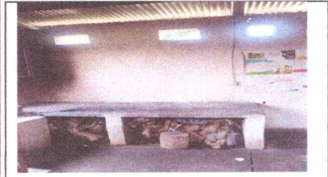
Foto 1: SUSTITUCION POR UNA MESA DE CONCRETO CON AZULEJO.
