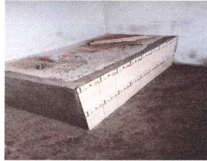
Foto 2: SE SOLICITA CAMBIO DE PLANCHA PARA COCINAR.
