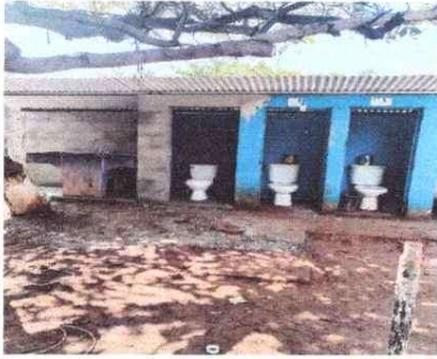
Foto 1: INSTALACION DE INIDOROS
