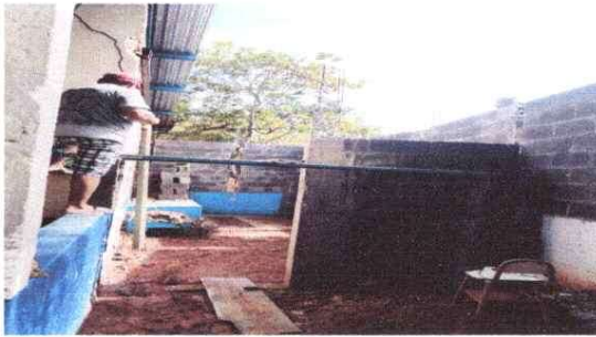
Foto 3: AREA UTILIZADA PARA COCINA.
