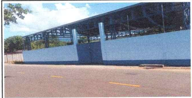
Foto 5: LEVANTADO Y COLOCACIÓN DE MALLA DE DOS METROS
