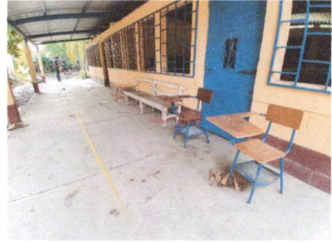
Foto 4: Medición de piso
