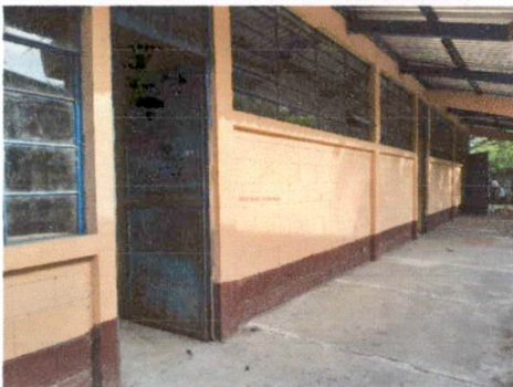
Foto 5: Estado actual de paredes
