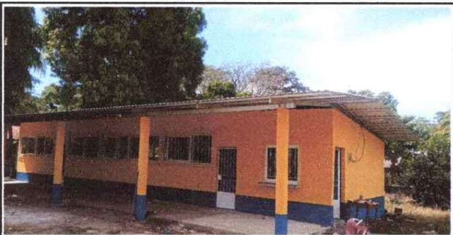
Foto 5: MEJORAMIENTO DE VENTANAS
