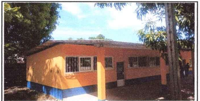
Foto 6: MEJORAMIENTO DE VENTANAS
