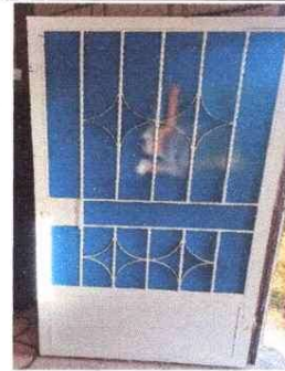
Foto 4: SUSTITUCION DE PUERTAS DE MADERA POR METAL
