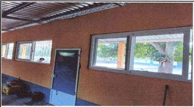
Foto 3: SUSTITUCION DE PUERTAS DE MADERA POR METAL
