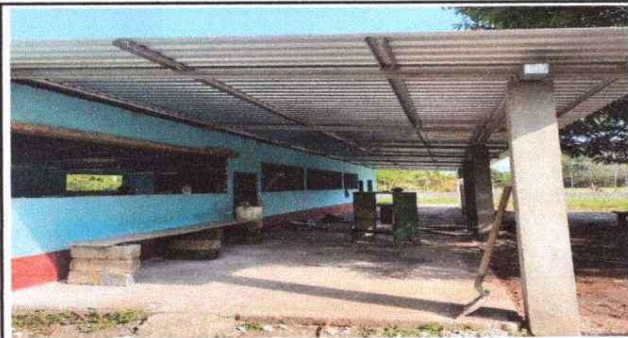
Foto 3: SUSTITUCION DE PUERTAS DE MADERA POR METAL
