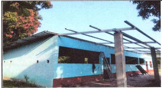
Foto 2: MEJORAMIENTO DE TECHO EN AULAS Y CORREDOR DE ESCUELA
