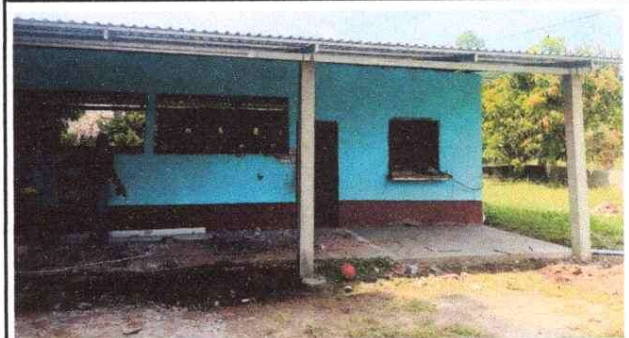
Foto 4: SUSTITUCION DE PUERTAS DE MADERA POR METAL
