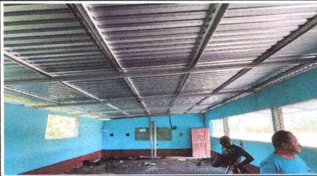
Foto 1: MEJORAMIENTO DE TECHO Y COSTANERA
