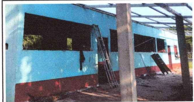
Foto 6: MEJORAMIENTO DE VENTANAS
