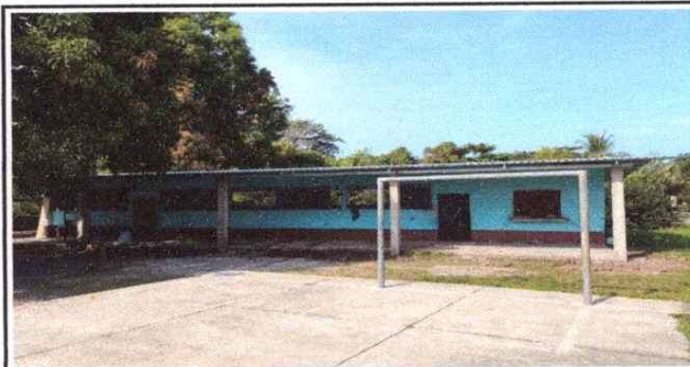
Foto 5: MEJORAMIENTO DE VENTANAS
