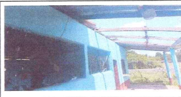
Foto 6: MEJORAMIENTO DE VENTANAS
