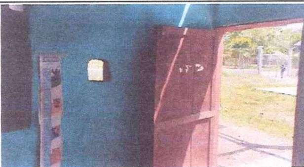
Foto 3: SUSTITUCION DE PUERTAS DE MADERA POR METAL
