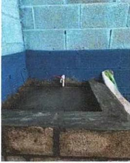
Foto 1: Instalación de lavamanos de cemento en area de sanitarios culminado.
