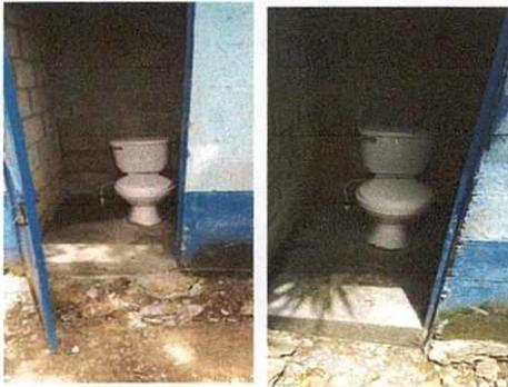
Foto 3: Finalización de trabajos de sustitución de sanitarios tipo letrina de plástico por sanitarios lavables de cerámica en párvulos
