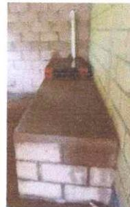
Foto 6: Mejoramiento de polletón de cemento con plancha metálica y chimenea en cocina, culminado.
